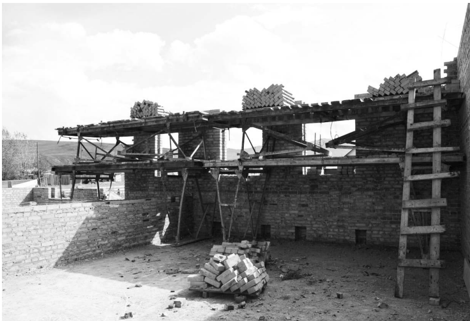
2019-ый год отметился для района ещё и крупными стройками и ремонтами. Некоторые из них будут продолжены в следующем году.
